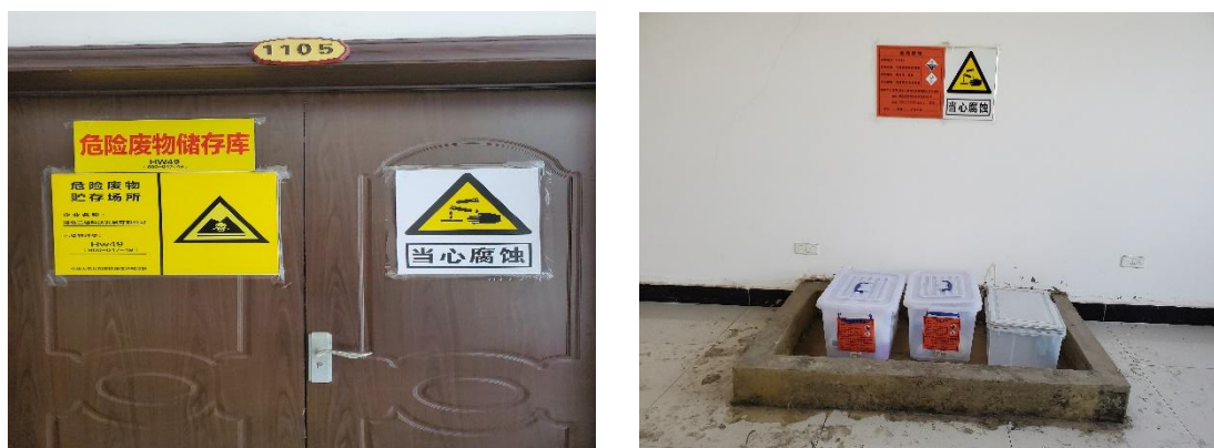
图 3-10 综合楼 1 楼危险废物仓库区隐患排查情况
