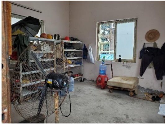
图 3-15 机修间隐患排查情况
