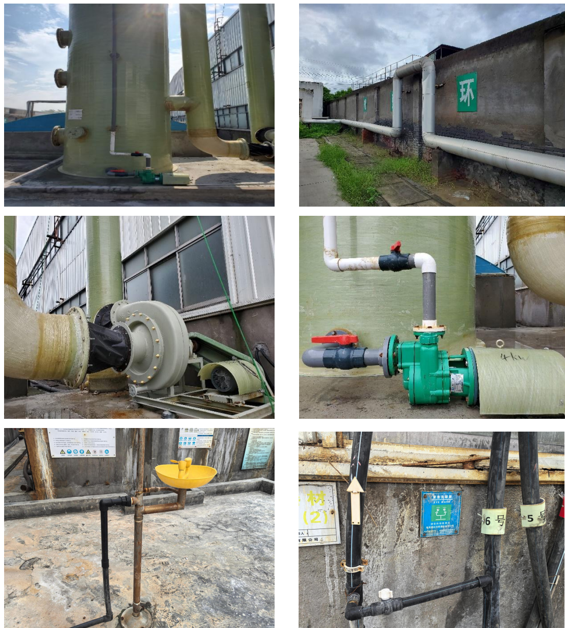
图 3-8 散状液体转运与厂内运输区隐患排查情况
