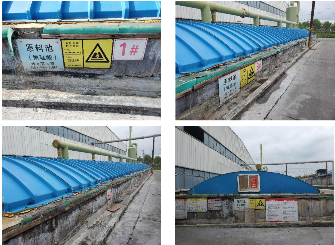
图 3-4 氟水池区隐患排查情况
