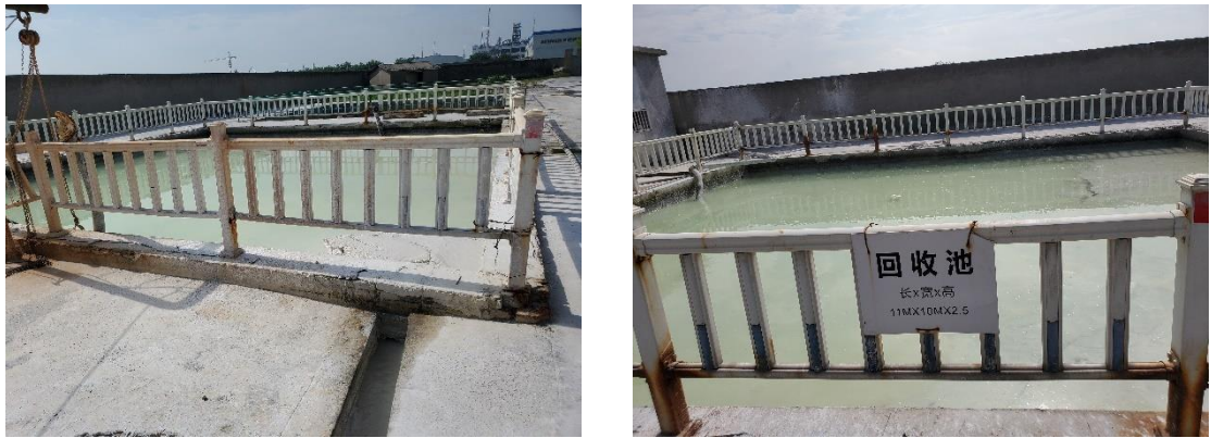
图 3-18 回收池隐患排查情况
