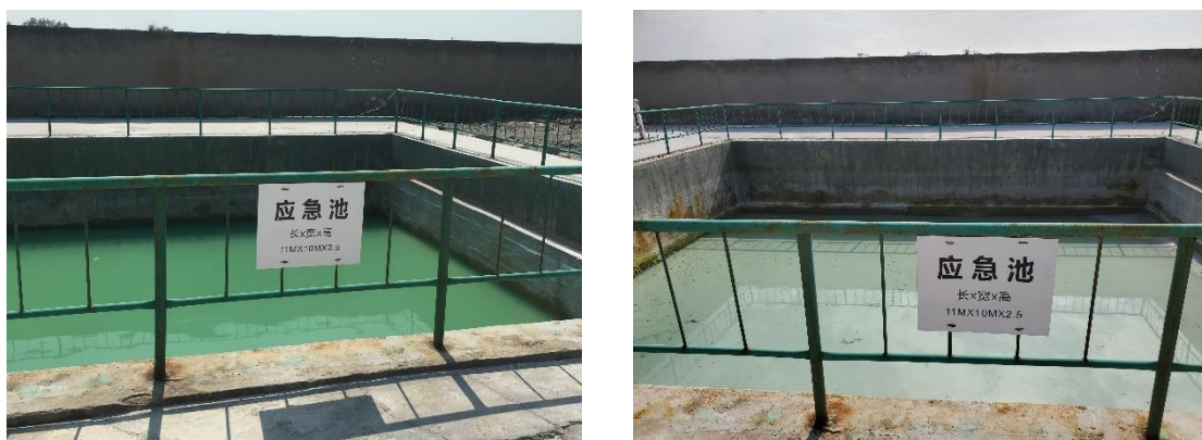
图 3-19 应急事故池隐患排查情况
