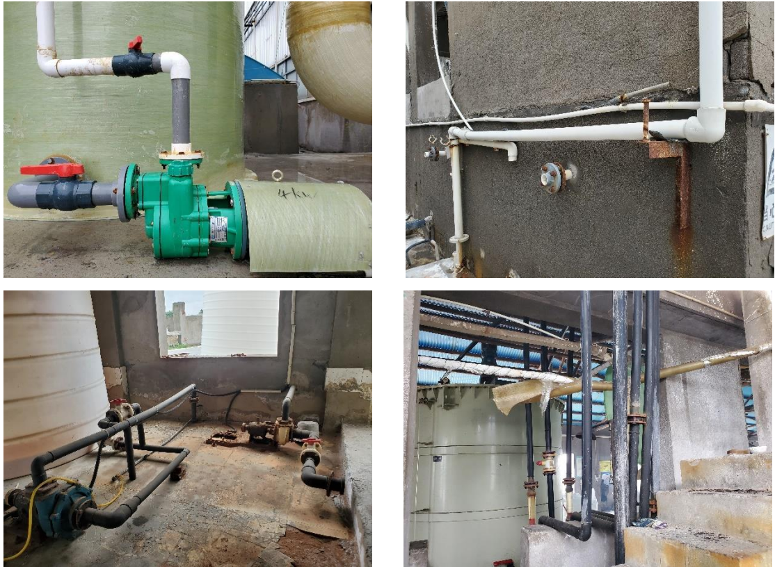
图 3-8 散状液体转运与厂内运输区隐患排查情况
